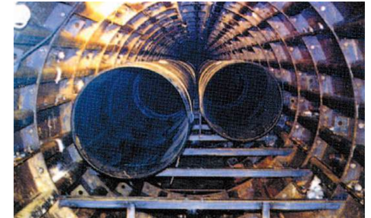
シールド内汚水管布設工事
