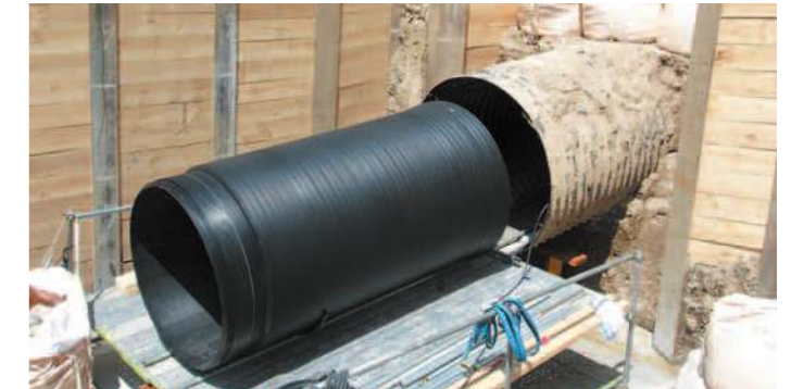
コルゲートパイプ更生工事
