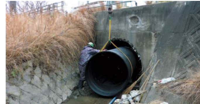
ビューム管更生工事
