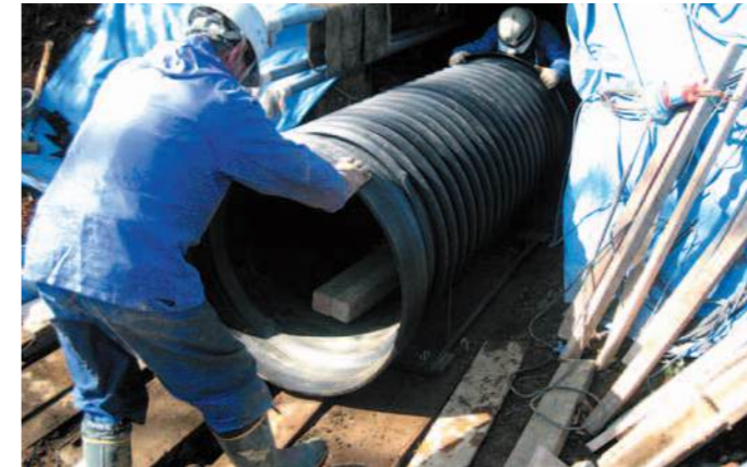
隧道更生工事
