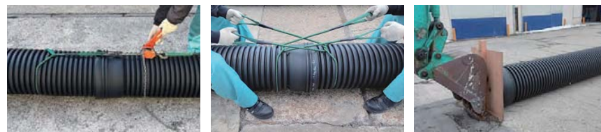
接続例① 挿入機を用いた接続
