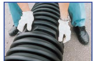
①ねじ込み受け口部にねじ込み内面パッキンが取付けてあるかを確認します。
