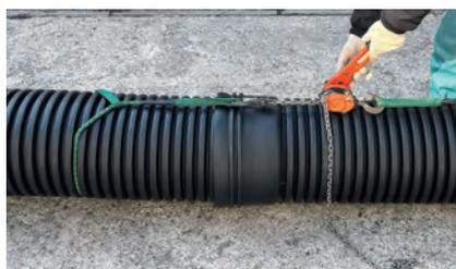
接続例① 挿入機を用いた接続
